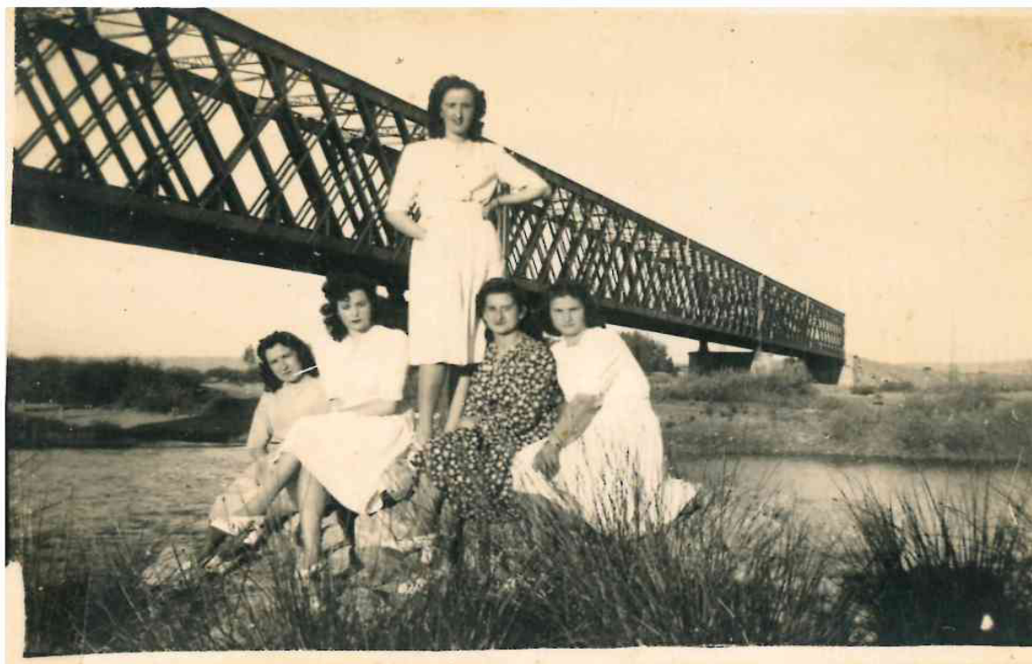
Fig.4 Puente de hierro sobre el Duero. Ferrocarril Torralba-Soria. Almazán 1940.
