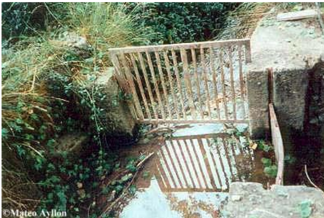
Compuertas del aliviadero
