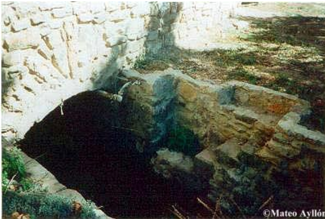
Acceso al cárcavo
