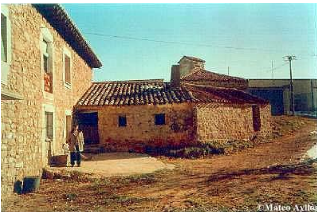
El horno, edificio anexo al molino
