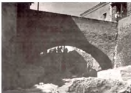
Puente de Santo Domingo, durante las obras de cubrición
