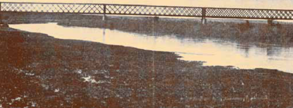
Puente de hierro de celosía armada.
